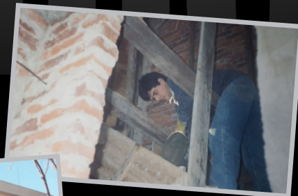
Trabajos en obra en 1993.
