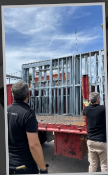
Paneliza, servicio de suministro y entrega de paneles en obra.
